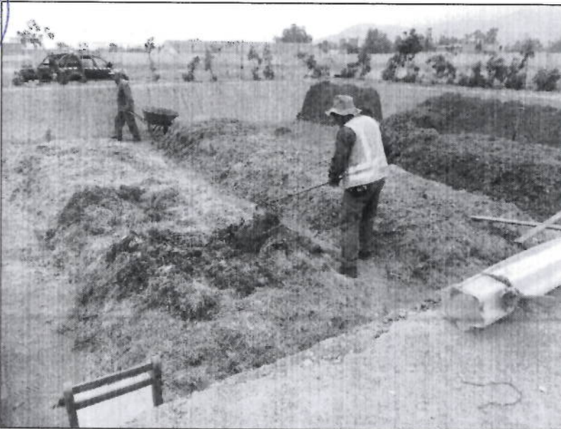
Foto N° 2: Humedecimiento de las pilas
